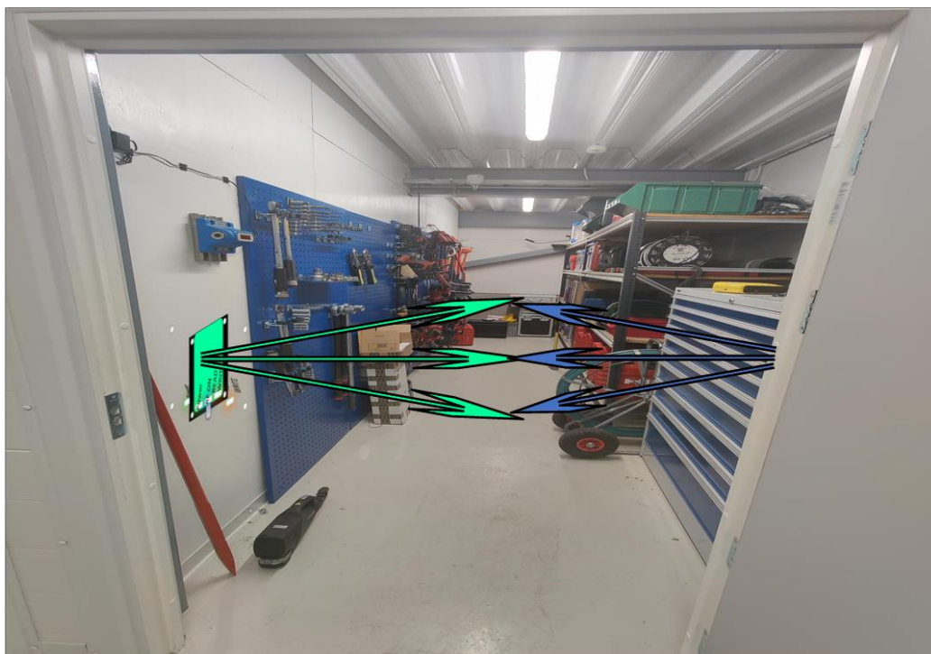
Figur 8-1: Verktøylager med illustrasjon av elektromagnetisk refleksjon fra verktøyskuff til perforert panel.
